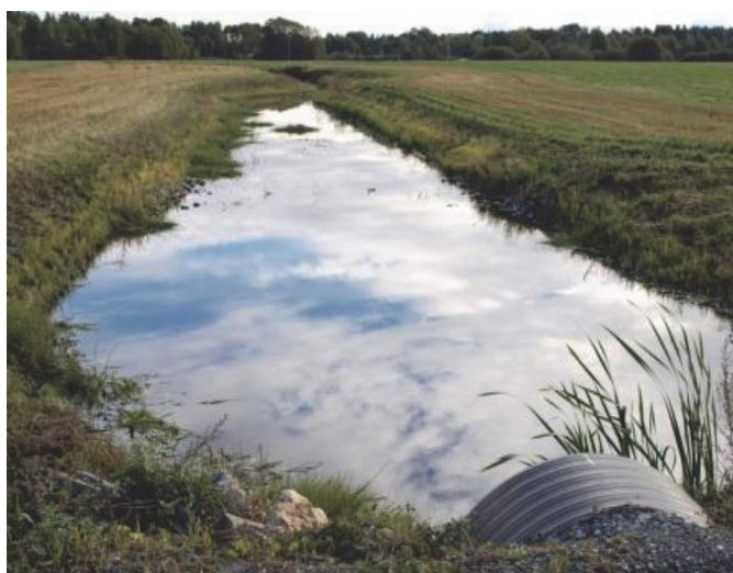
Ten staw sedimentacyjny powstał poprzez poszerzenie części rowu. Na pierwszym planie, tuż po wejściu, jest głębszy zbiornik sedimentacyjny (fot. S. Owenius)
